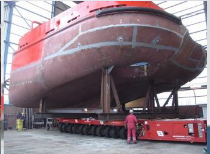
SERKEBORG in aanbouw bij Kon. Niestern Sander B.V. te Delfzijl onder bouwnummer 845, 3-4-2012, plaatsen ring 1 en 2, foto's: J. Tuil.
