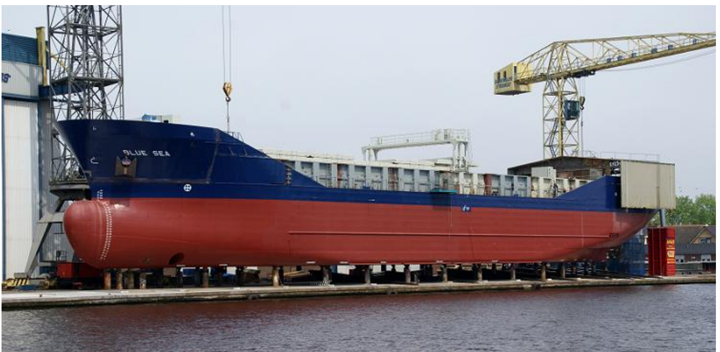
BLUE SEA 9361110, in aanbouw bij Barkmeijer Stroobos, foto: K. Goudriaan, 13-5-2008.
